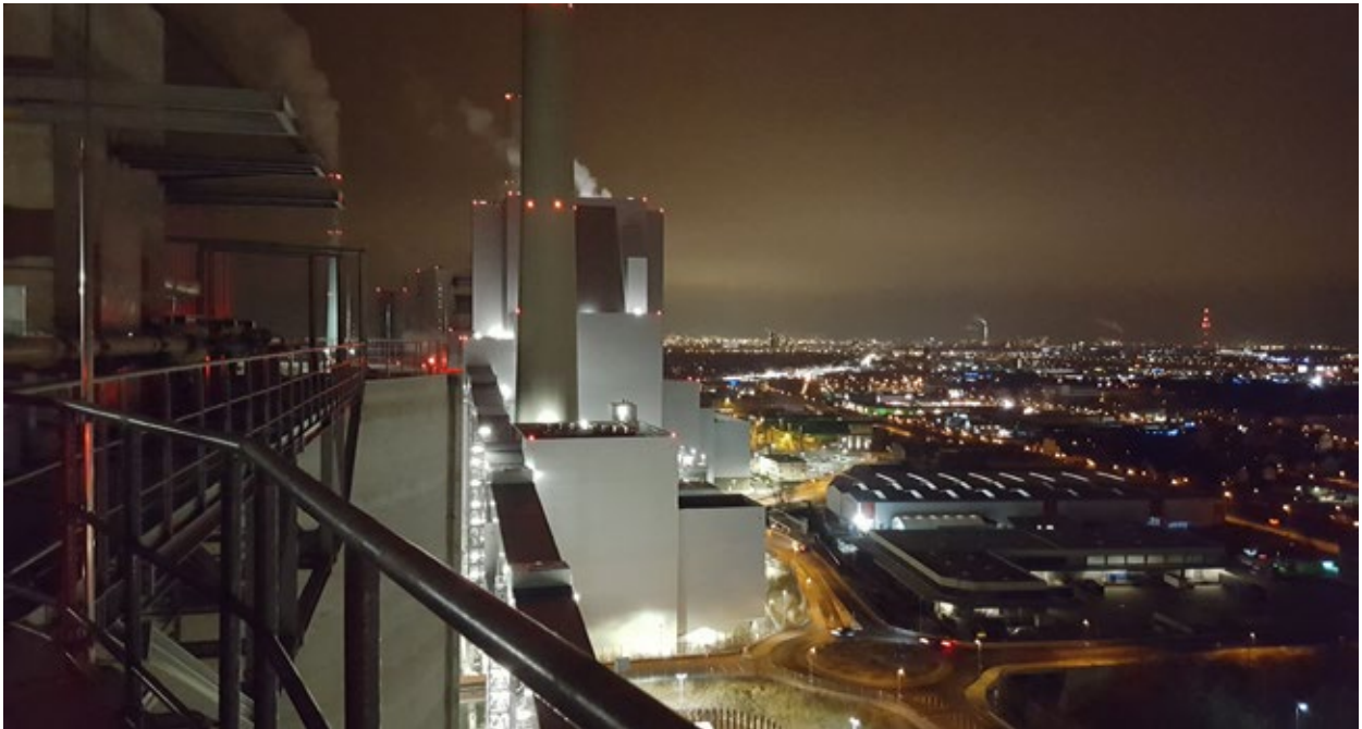
Blick vom Großkraftwerk Mannheim (forum generale in tour)
